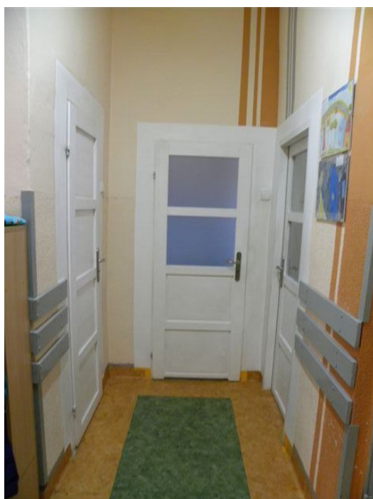
Rys. 5. Przykładowe miejsca montażu samozamykaczy
