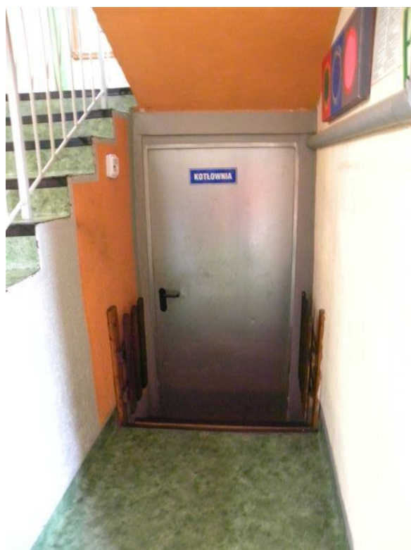
Rys. 3. Drzwi do piwnicy oraz miejsce montażu barierki zabezpieczającej
