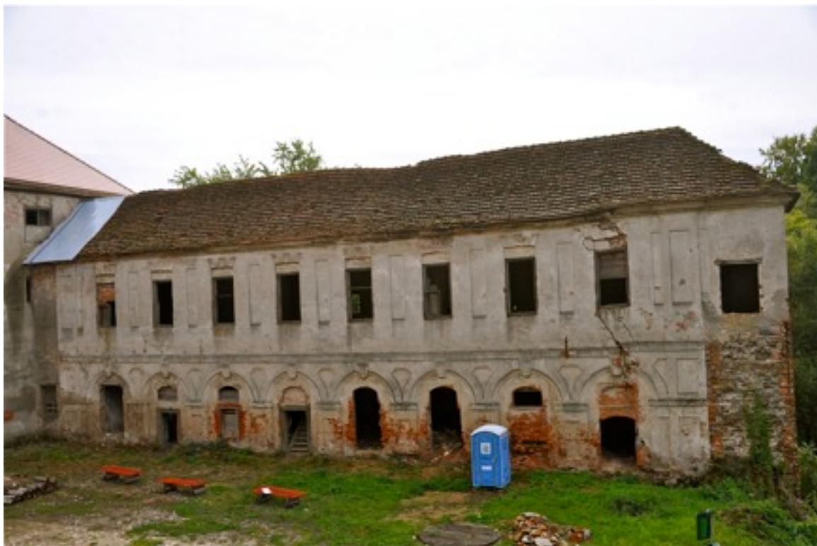
Na zdjęciu widok na elewację północną skrzydła południowego
