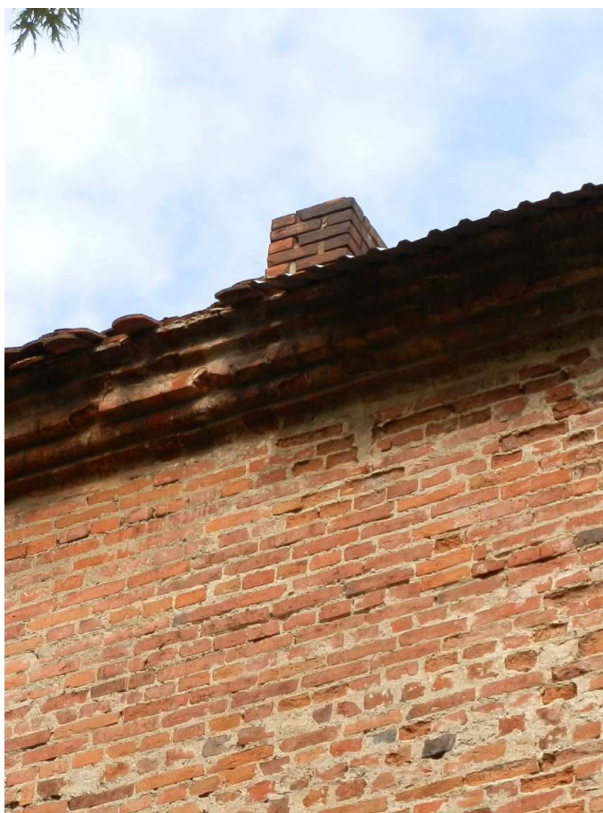
KOMIN Z CEGŁY WSPÓŁCZESNEJ - SKRZYDŁO POŁUDNIOWE
