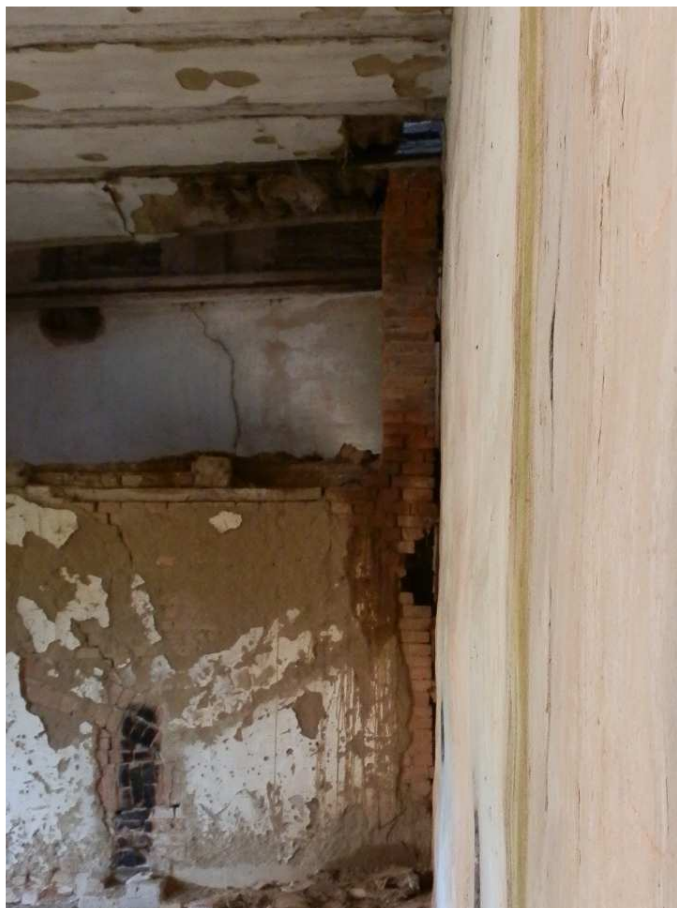
KOMIN Z CEGŁY WSPÓŁCZESNEJ, NIE POŁĄCZONY ZE ŚCIANĄ ZEWNĘTRZNĄ - SKRZYDŁO POŁUDNIOWE
