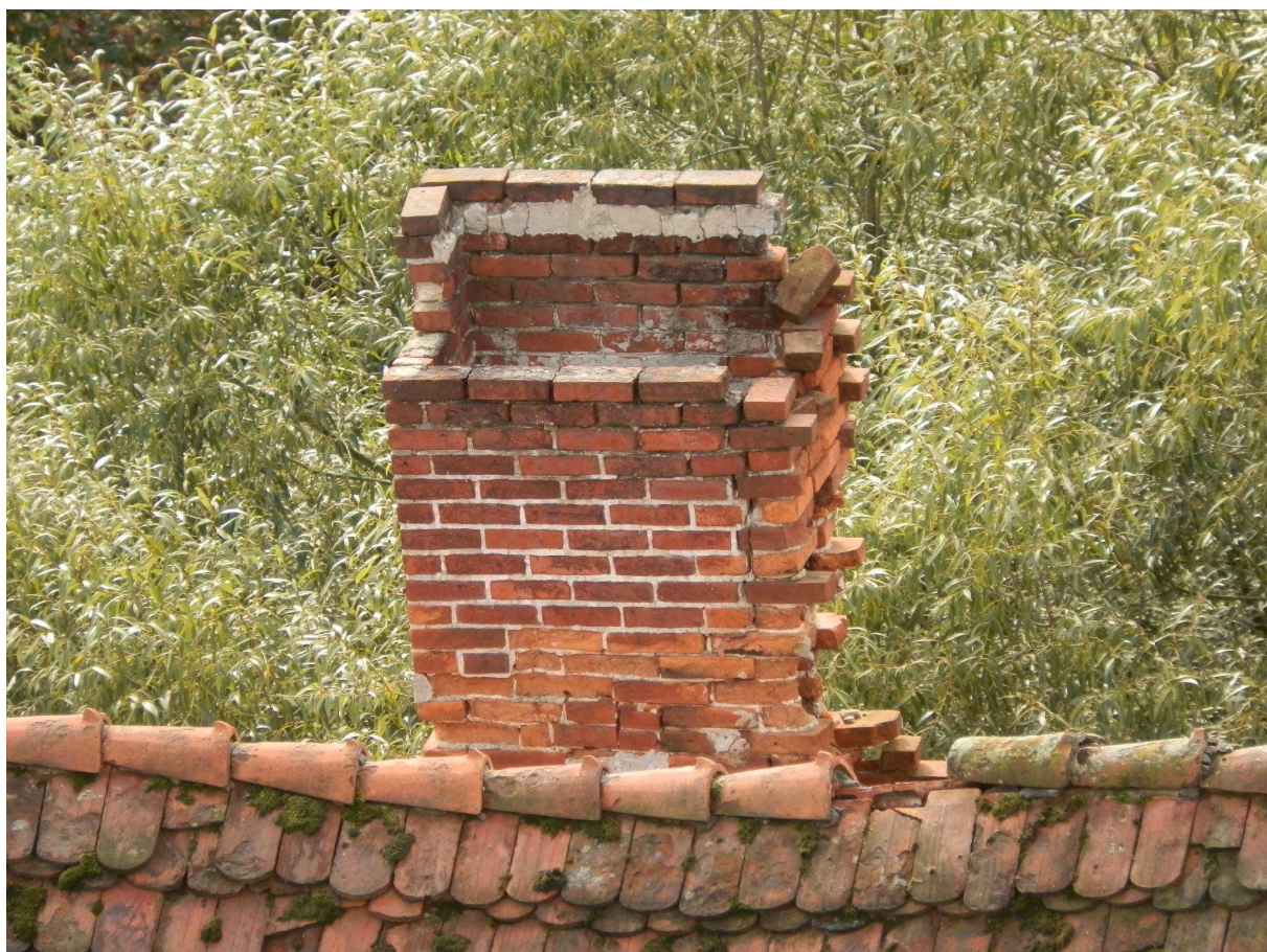
KOMIN WYKUSZOWY WYPROWADZONY ZE ŚCIANY ZEWNĘTRZNEJ - SKRZYDŁO POŁUDNIOWE
