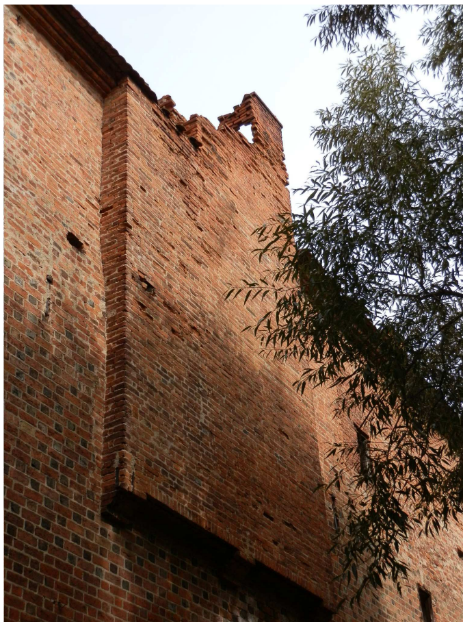
KOMIN WYKUSZOWY WYPROWADZONY ZE ŚCIANY ZEWNĘTRZNEJ - SKRZYDŁO POŁUDNIOWE
